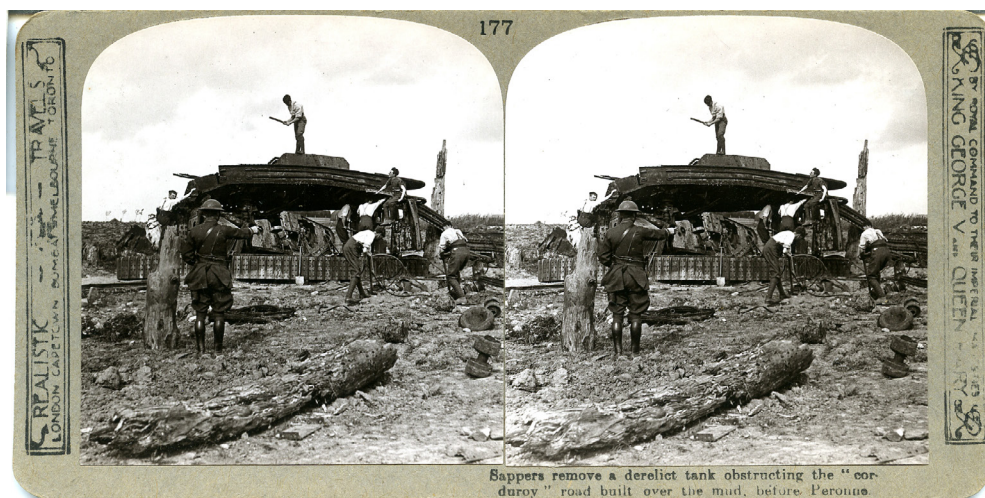
Илл. 2. Инженерные войска убирают брошенный танк, мешающий строительству настилов на подступах к Перону.
